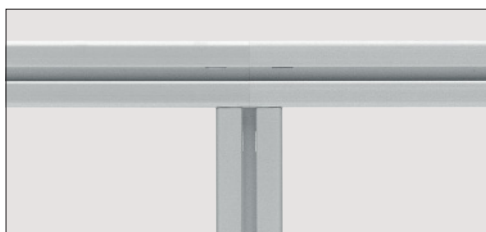
Unterstützung einer Nahtstelle
